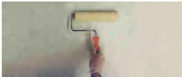
Sello de un piso autonivelante con un sello mate, utilizando rodillo de pelo corto
