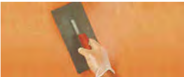
Sellado con llana lisa de una capa de arena de cuarzo regada superficialmente
