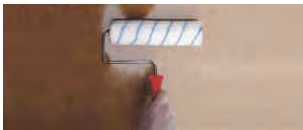
Aplicación del imprimante con rodillo de pelo medio a largo
