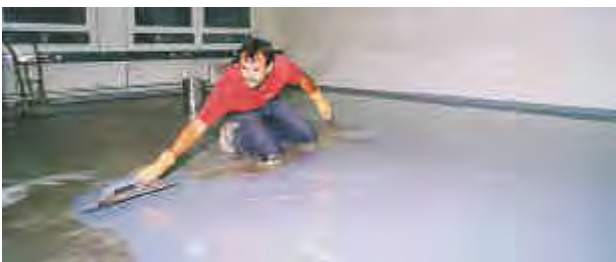
Aplicación de un mortero autonivelante con llana dentada
