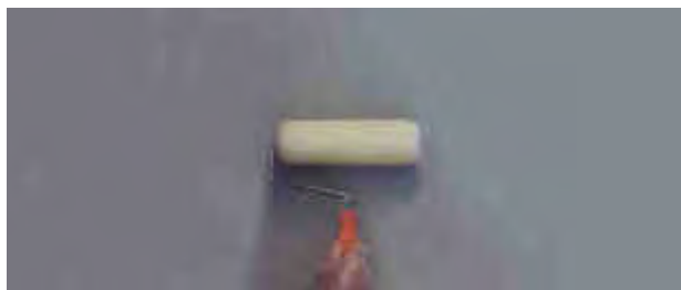
Aplicación de Sikafloor®-205 con rodillo texturizado
